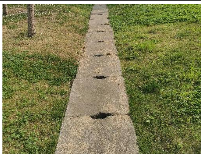
现场调查（排水现状）
