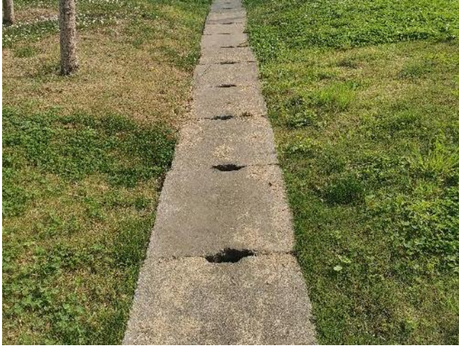
现场调查（排水现状）
